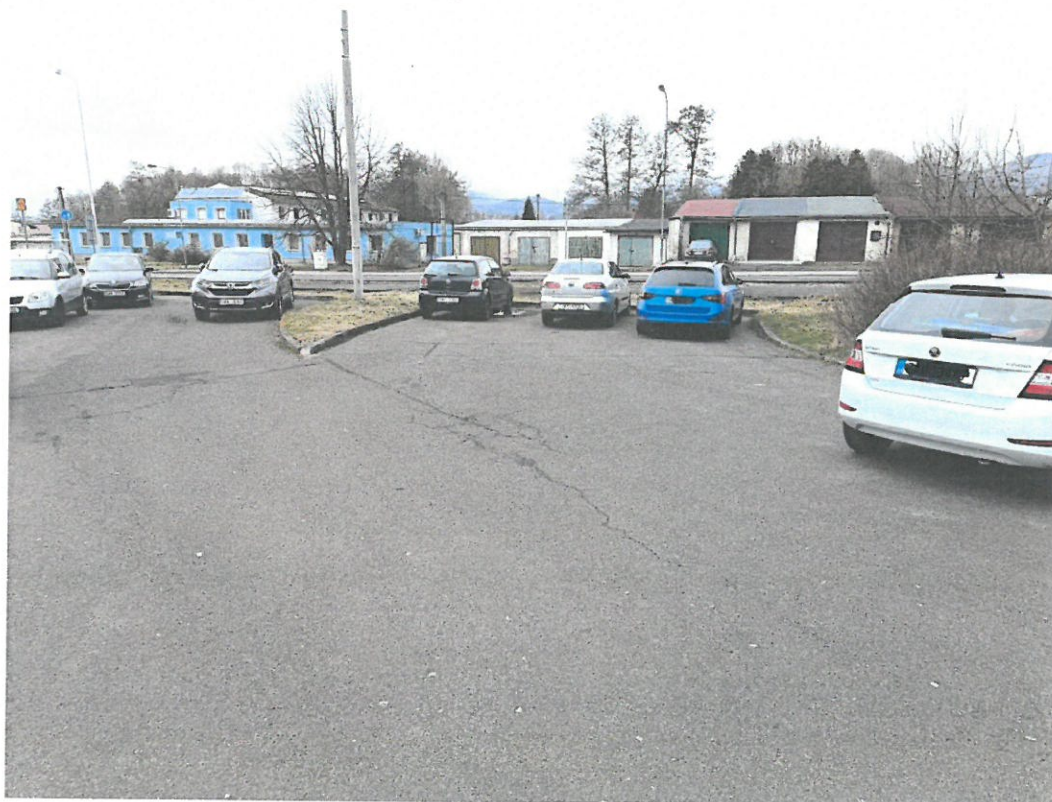
Obr. č. 6 – Foto stávající stav – západní větev:
